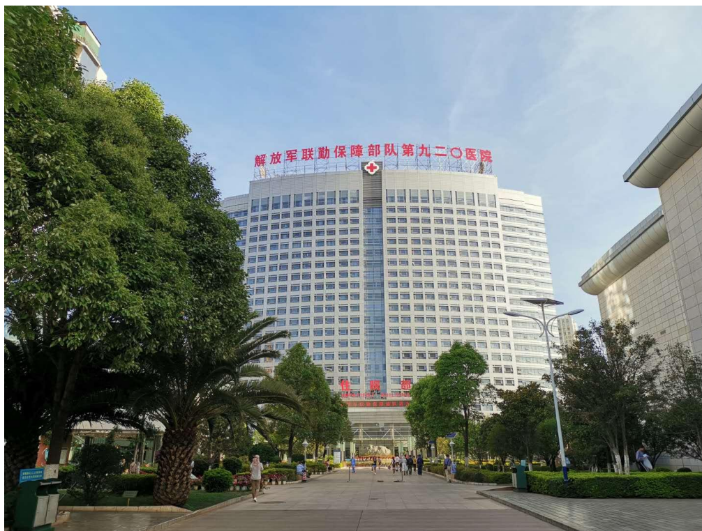
（医院住院大楼）
